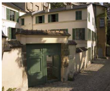
Vue de l'entrée de la Maison de Balzac, côté rue Berton
